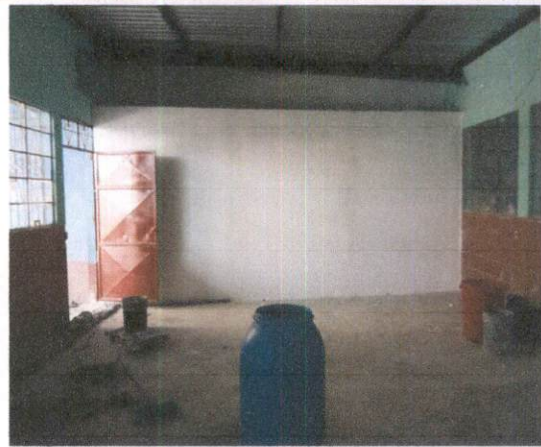
Foto 4: Reparación de pared del aula de preprimaria.
